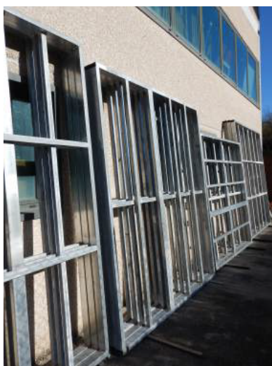
TELAIO DI TUBOLARE IN FERRO ZINCATO A CALDO PER IMPOSTA PARETI PERIMETRALI A MISURA, ASSEMBLATI E SALDATI
